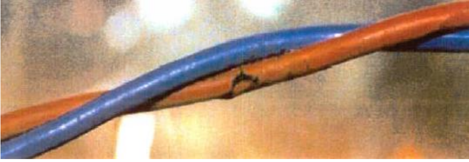
Resim 5.1: Hasarlı uçak elektrik kabloları
