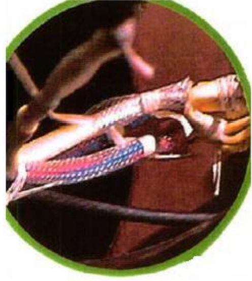
Resim 5.3: Özel koruyucu kılıf içine alınmış elektrik kabloları
