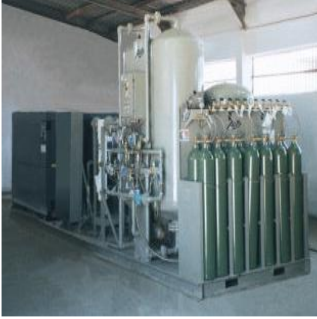
Resim 1. 5: Oksijenin üretimden sonra tüplere doldurulması
