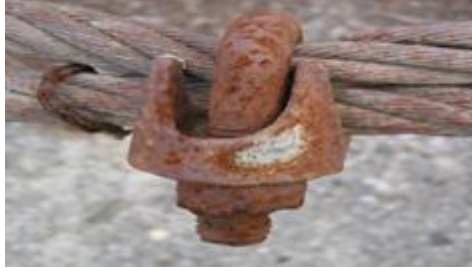
Resim 1.11: Korozyona uğramış tel halat
