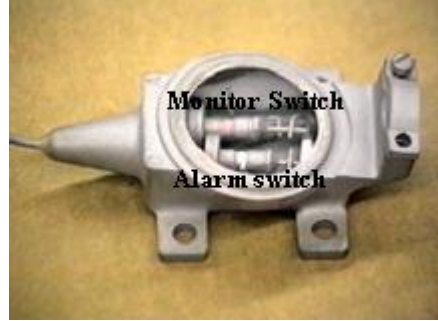
Resim 1.3: Basınçlı yangın dedektörü kontaktarı
