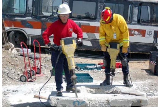
Resim 3.5: Titreşim esaslı asfalt kırma makinesi
